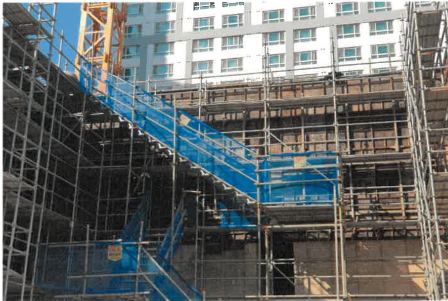
( 지상3층 외부 안전계단 설치 )
