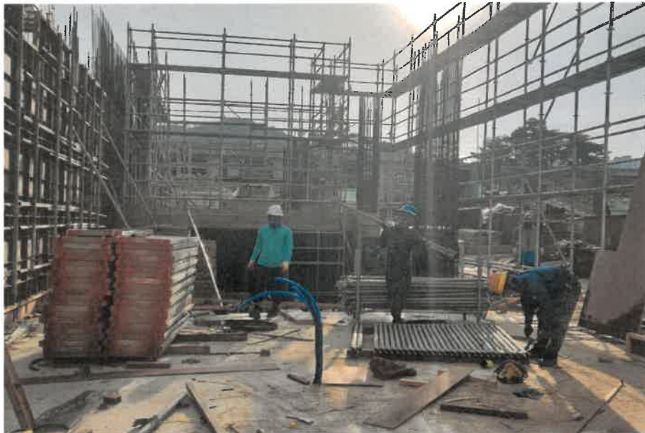
( 1층 외부 시스템 비계 설치 )
