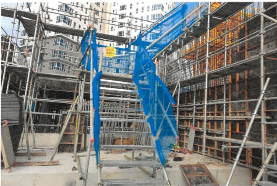
( 지하2층 외부 안전계단 설치 )
