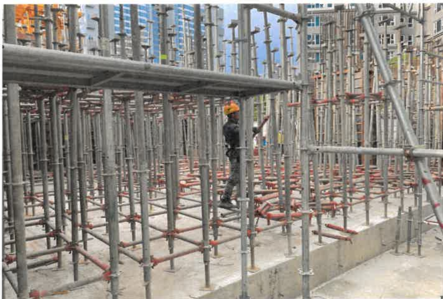
( 1층 내부 시스템 동바리 설치 )
