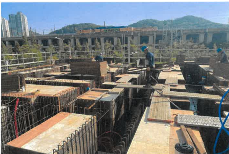
( 2층 전이보 거푸집 및 철근 설치 )
